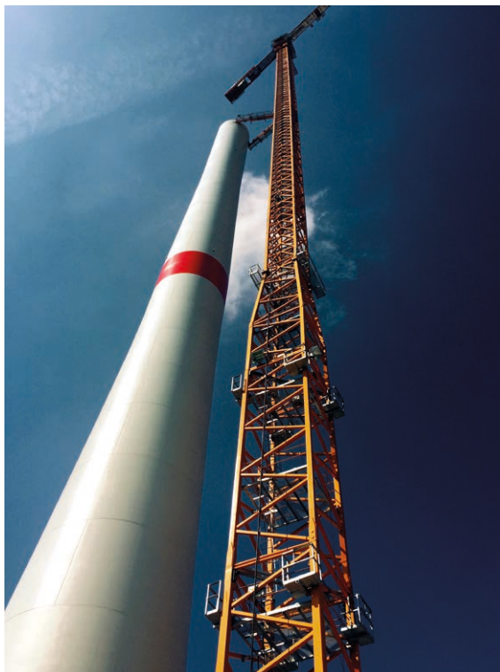
Bild 1 Hybridturm aus Fertigbeton-Elementen
