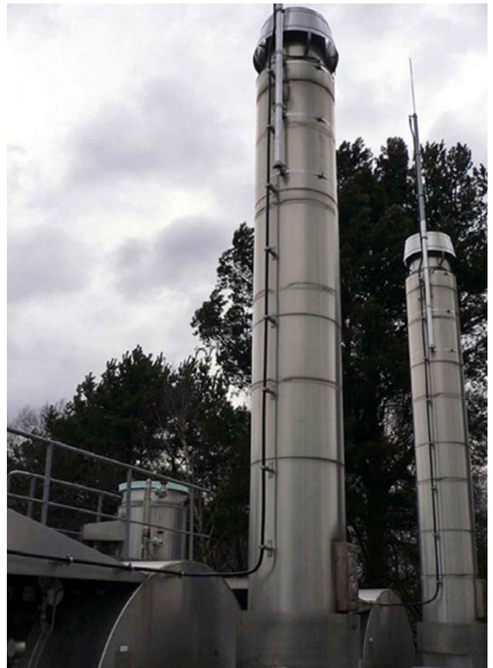
Verlegung der HVI®Leitung in der Ex-Zone.
