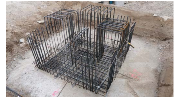
3b) Darstellung der Verbindungsleitung bzw. des Anschlusspunktes zur Anbindung von Einzel-fundamenten an die Erdungsanlage
