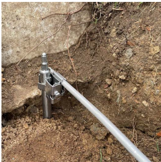
Fachgerechte Installation eines Tiefenerder NIRO (V4A)
