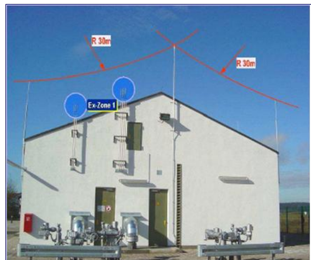
Bild 2: Schutz der GDRM-Anlage mit getrennter Fangeinrichtung
